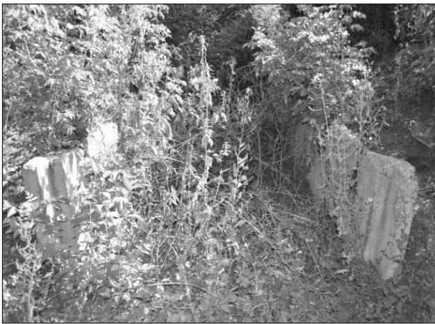
Рис. 5. Фото гідротехнічної споруди – лотка, який не виконав свою функцію, по обидві боки утворилися 2 глибокі яри
